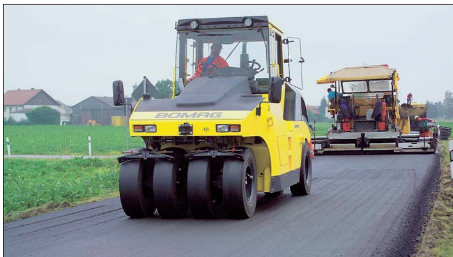
Модели BW 24 RH и BW 27 RH представляют собою гибкие в работе дорожные катки на пневматических шинах для проведения уплотнительных работ по асфальту и земляных работ.
