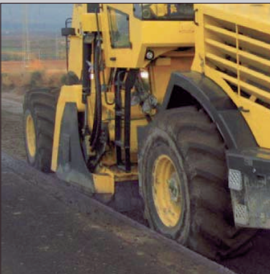
Возможно двустороннее фрезерование у края дорожного полотна.
