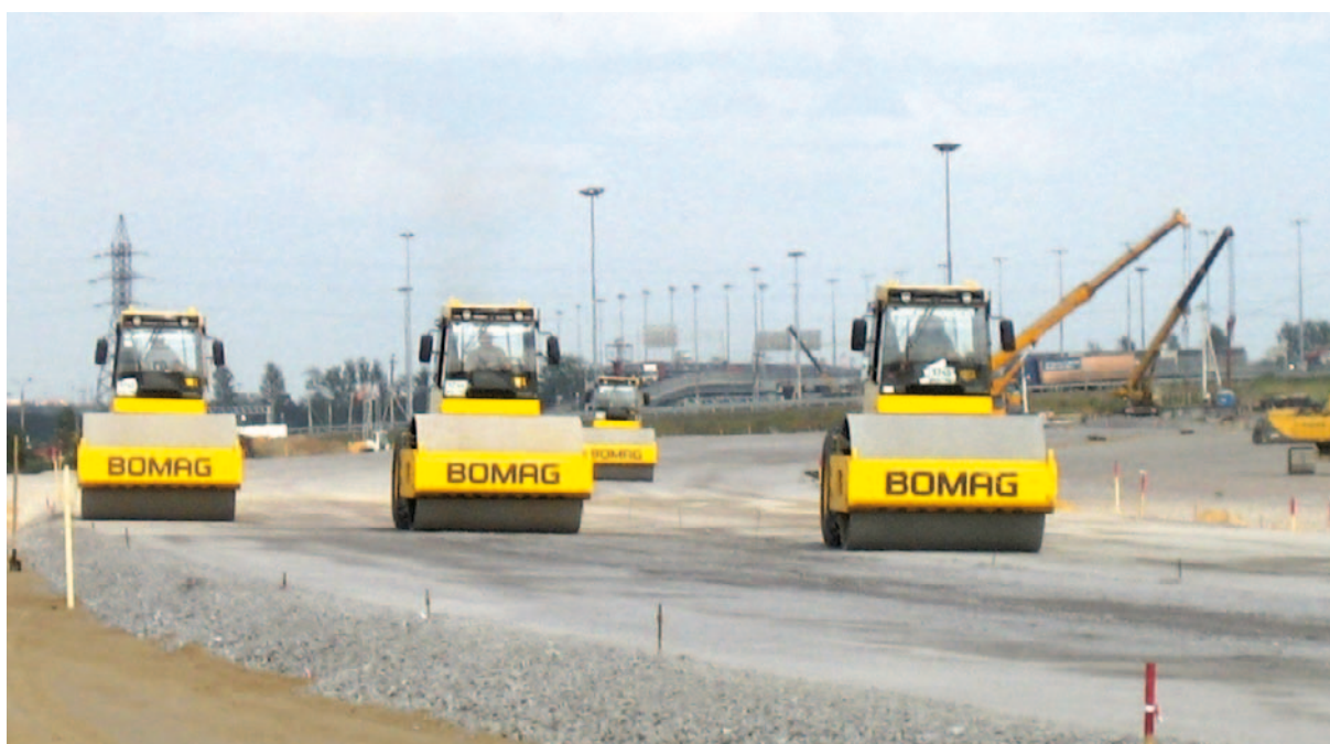
Грунтовые катки фирмы BOMAG при осуществлении работ по уплотнению в Санкт-Петербурге.
